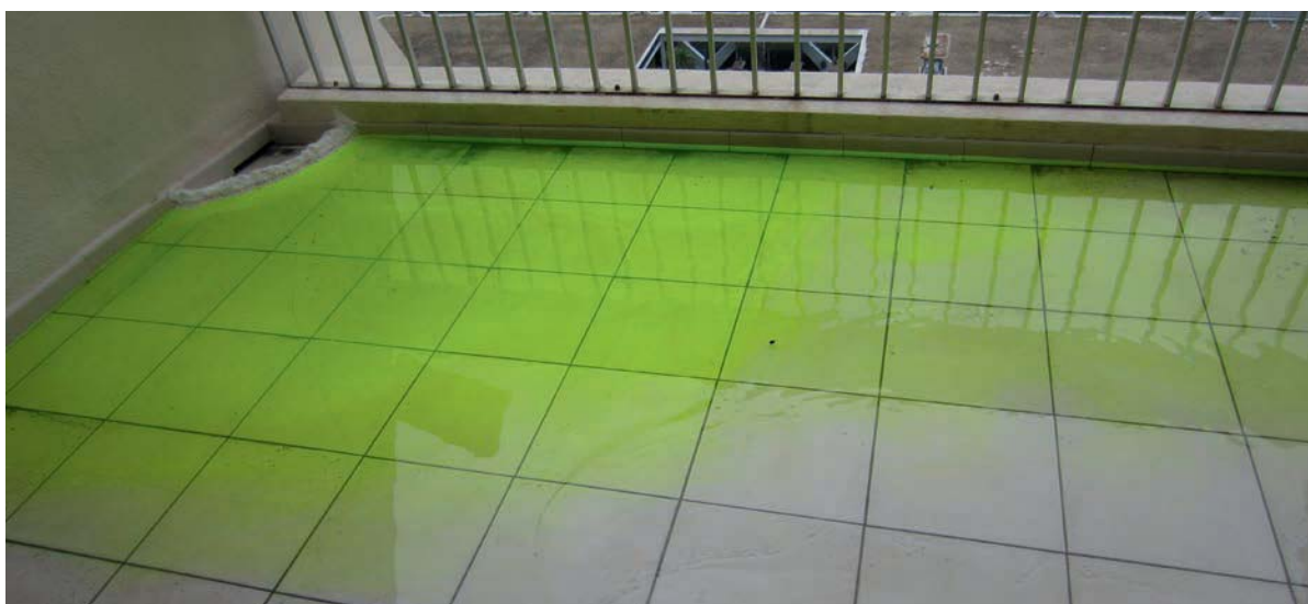
Mise en eau d'une terrasse à l'aide de colorant.
